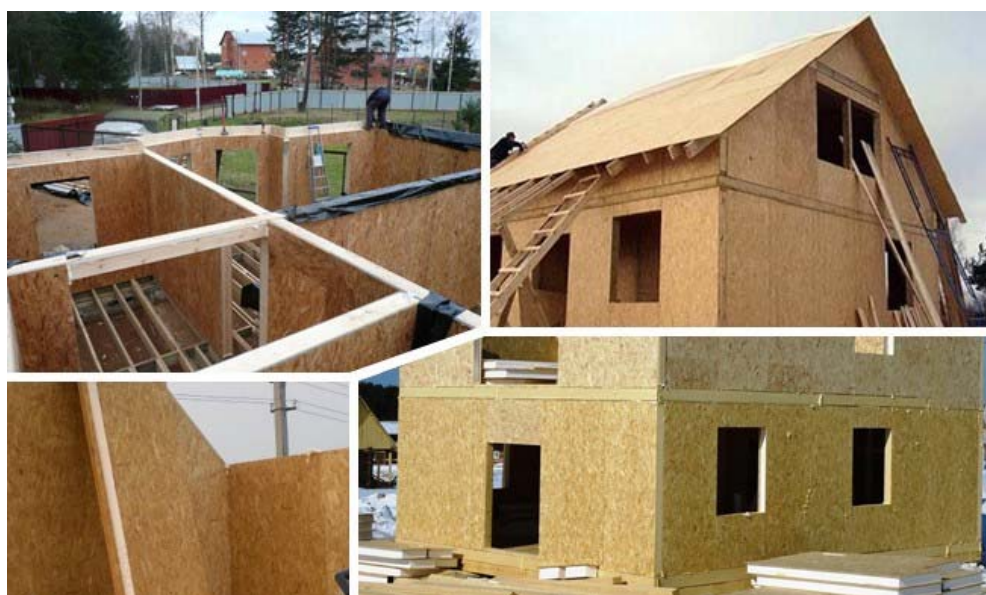
Рис. 18. Сборка дома из SIP-панелей
