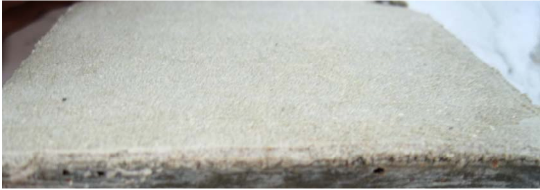
Рис. 3.33. Внешний вид покрытия до испытаний
