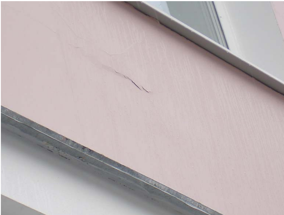
Рис. 5.18. Фотография фасада здания после 1 года эксплуатации известкового покрытия
