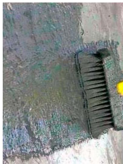
Рис.23. Устройство гидроизоляции проникающего действия
