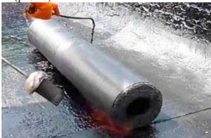
Рис.20. Устройство оклеечной гидроизоляции
