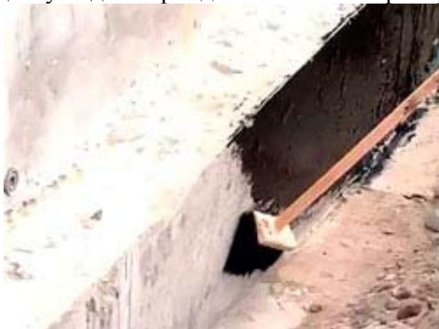
Рис.19. Устройство окрасочной гидроизоляции
