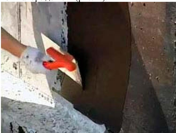
Рис.21. Устройство штукатурно-цементной гидроизоляции
