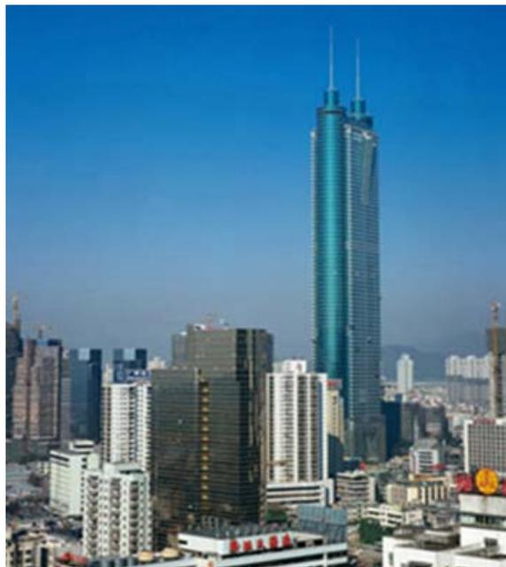
Рис. 35. Здание с каркасом из труботетона на площади Сайгэ в Шэньчжэне, КНР (72 этажа)
