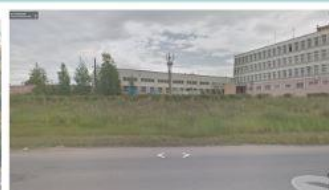
Котельная в Арбеково
