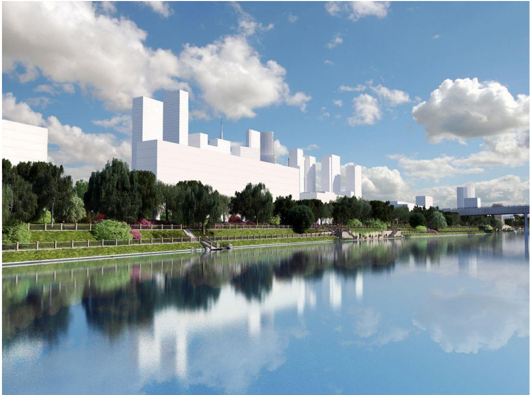
Рисунок 12 – Участок от Белорусского ж/д моста до проектируемого моста в створе Берегового проезда, г. Москва
