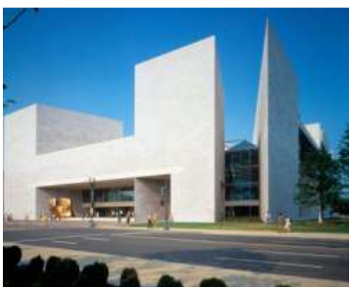
Рис. 7 Восточное крыло. Фасад
