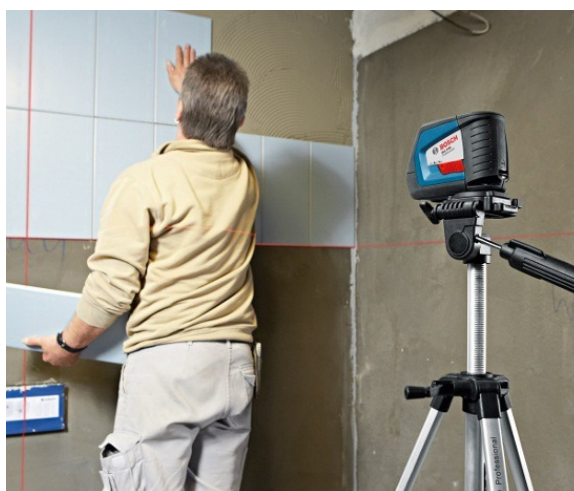
Рис. 54. Нивелир «Bosch GLL 2-50 Professional», используемый в качестве ориентира для повышения точности ремонтных и строительных работ
