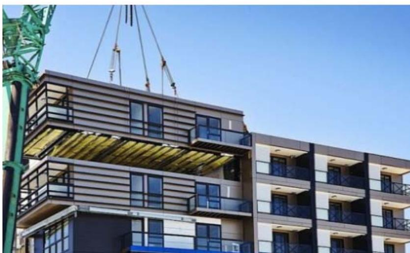
Рис. 2.34. Установка жилого блока
