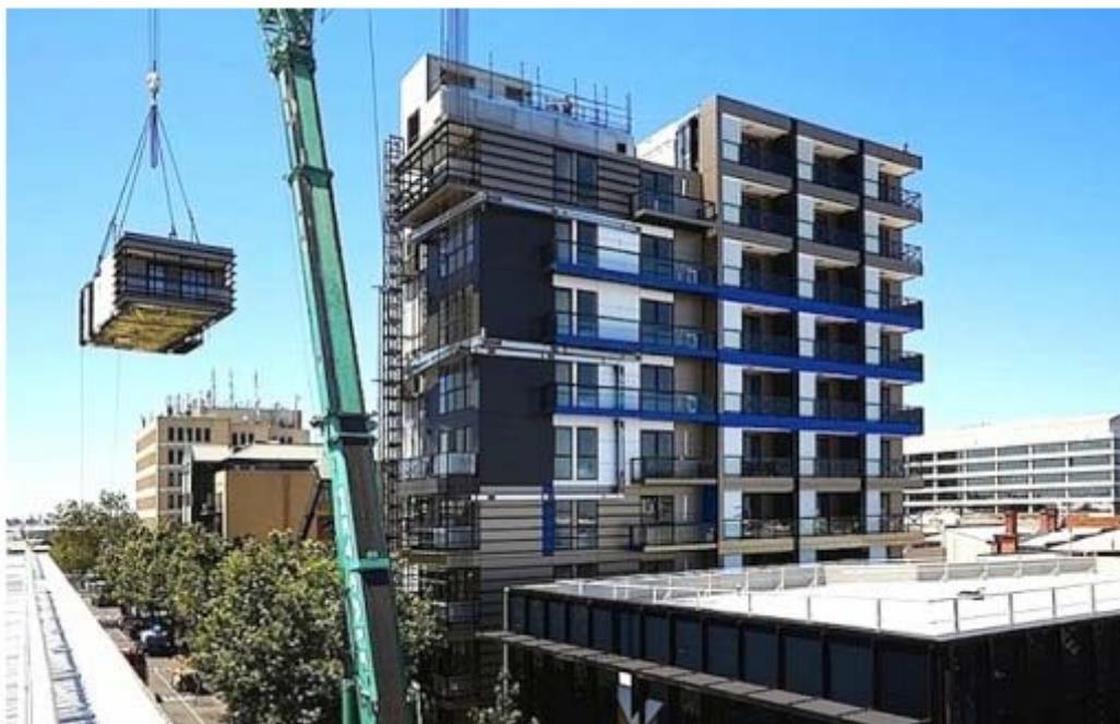
Рис. 2.33. Установка жилого блока
