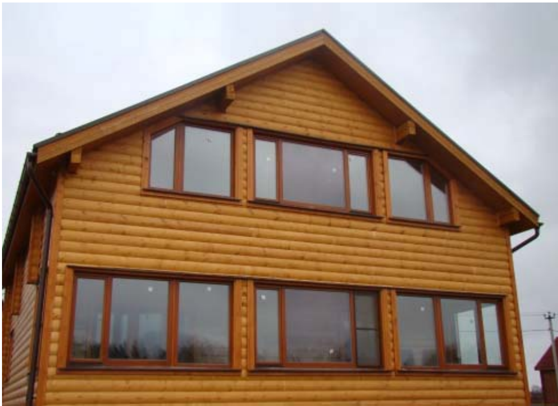
Рис. 19. Виды отделки наружных стен малоэтажных домов (продолжение)
