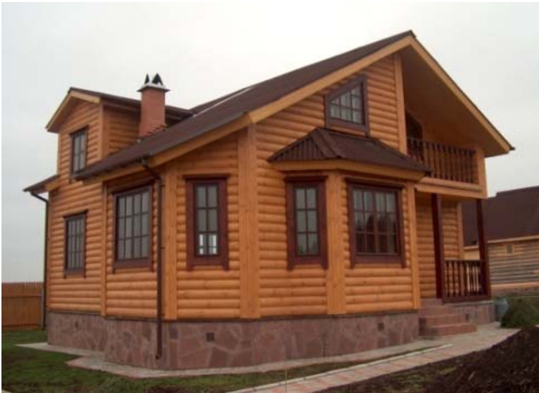
Рис. 19. Виды отделки наружных стен малоэтажных домов (продолжение)
