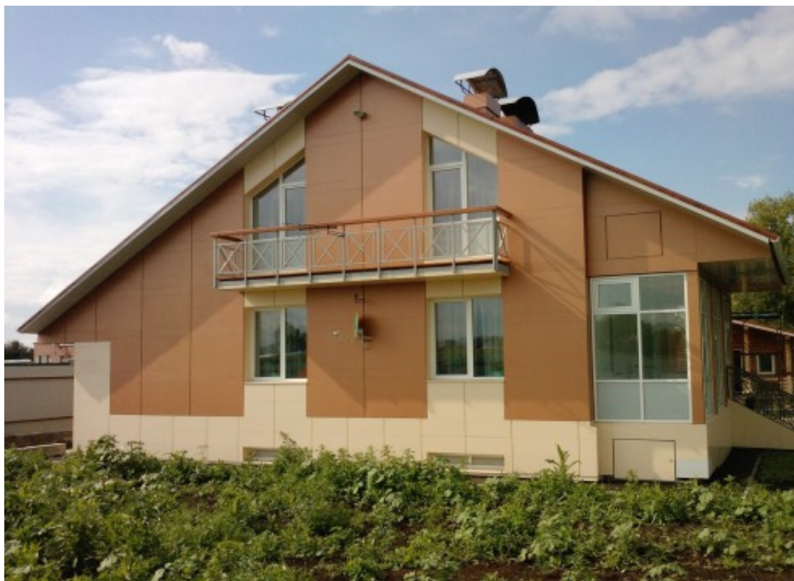
Рис. 19. Виды отделки наружных стен малоэтажных домов (продолжение)
