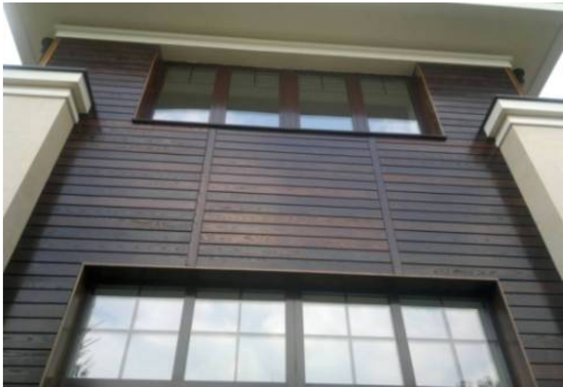
Рис. 19. Виды отделки наружных стен малоэтажных домов (продолжение)
