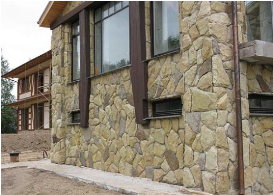
Рис. 19. Виды отделки наружных стен малоэтажных домов (продолжение)
