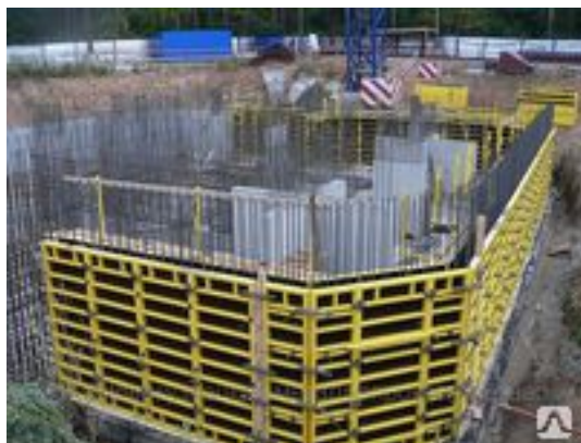
Рис. 4.6. Крупнощитовая опалубка
