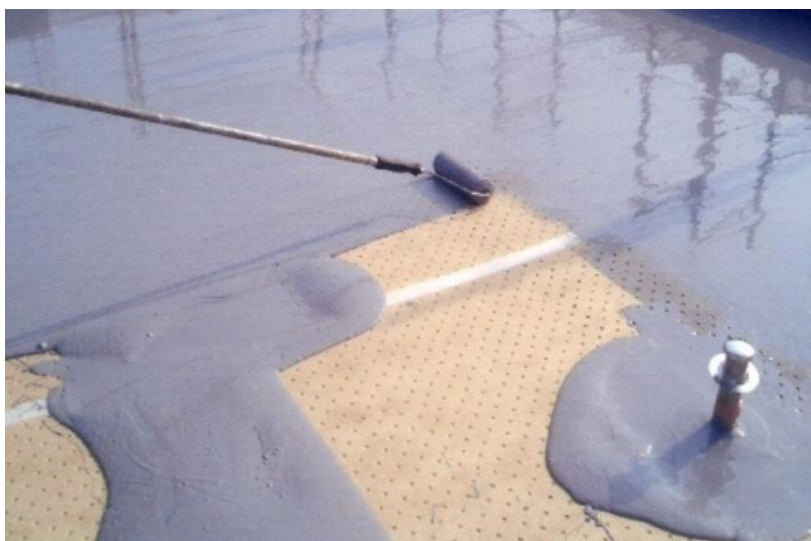
Рис. 6.6. Нанесение мастичного материала
