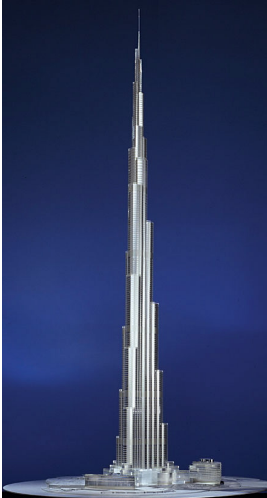
Рис.4.2. «Бурдж-Халифа» – «Башня Халифа» (до 2010 года называлась «Бурдж Дубай»)
