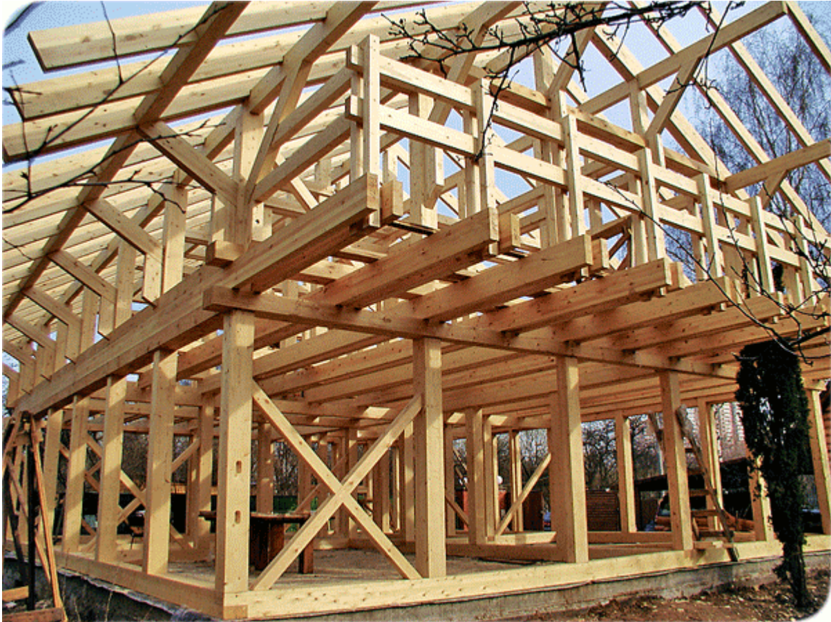
Рис. 2.1. Деревянный каркас дома
