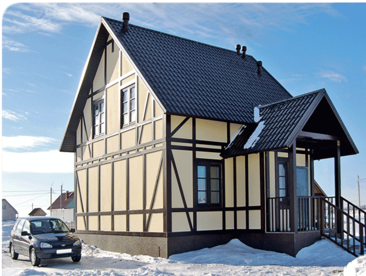
Рис. 2.9. Каркасно-панельная постройка с накладным «фахверковым» декором (ТАМАК)
