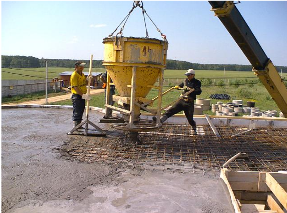
Рис.4.9. Бадья для подачи бетонной смеси к месту укладки
