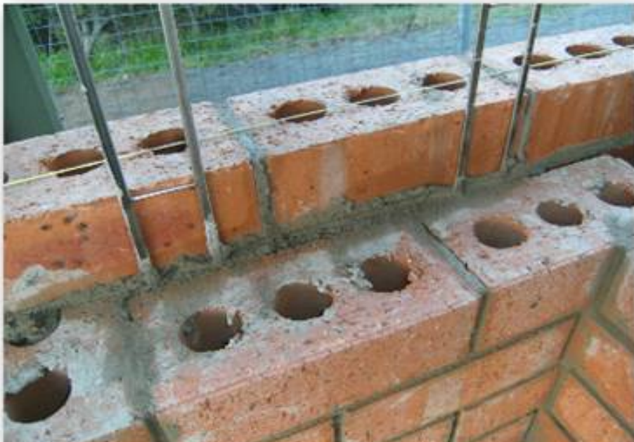
Рис. 1.16. Продольное армирование кладки
