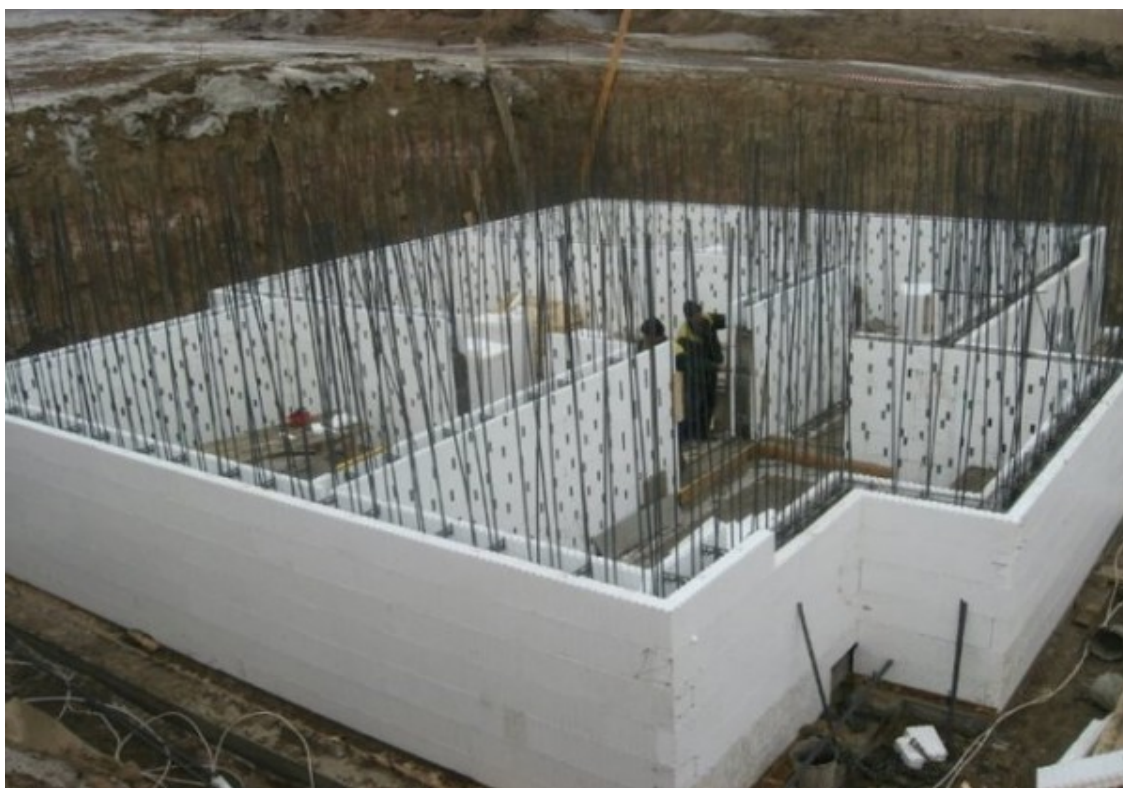
Рис. 4.18. Строительство дома с применением несъемной опалубки
