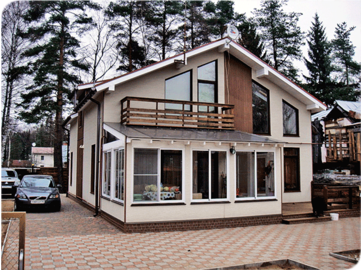
Рис. 2.2. Коттедж на основе каркаса с SIP – панелями. Фасад отделан декоративной штукатуркой (PolarSip)
