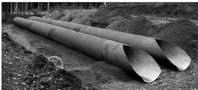
Рис. 1.23. Общий вид гофрированных труб со срезом
