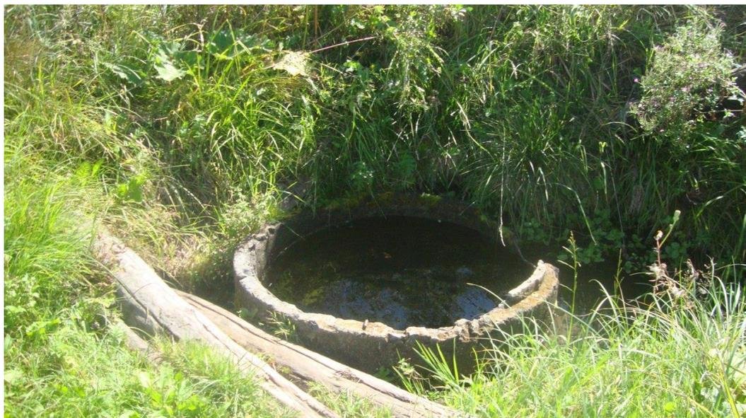
Рисунок 2.1 Необустроенный трубчатый колодец в с. Новые Пичуры
