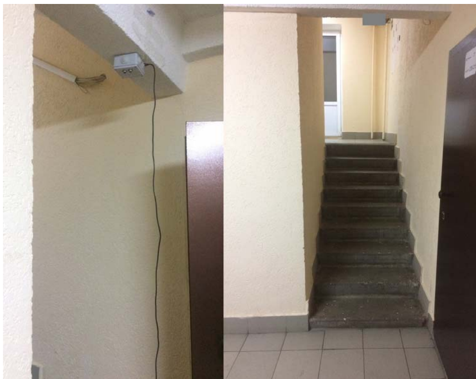
Рис.2.2. Схема установки датчика на лестнице
