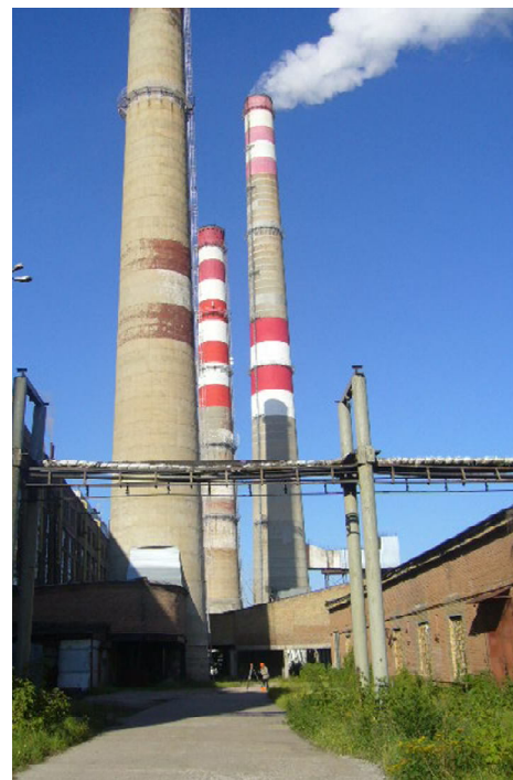
Обследование труб ТЭЦ.
