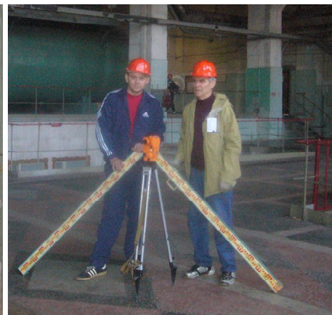
Т.И.Хаметов и А.И.Чурсин. Планово-высотная съемка подкрановых путей мостового крана.
