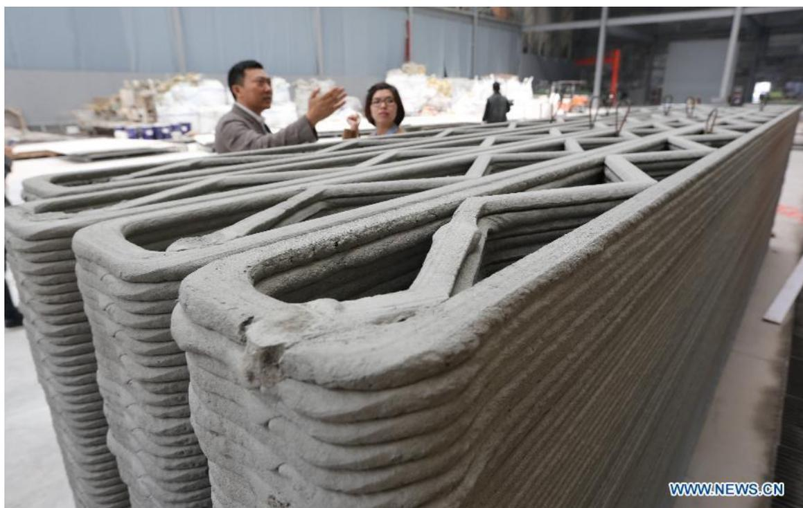
Рисунок 2.27 – Строение дома из 3D принтера
