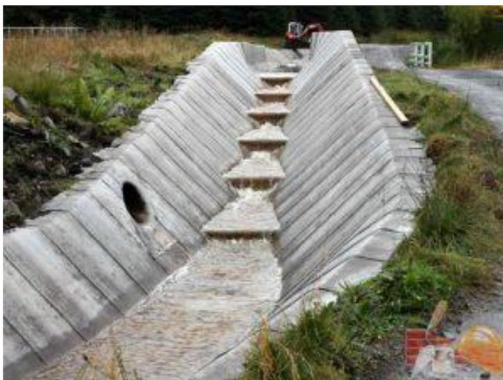
Рисунок 2.16 – Бетонный холст
