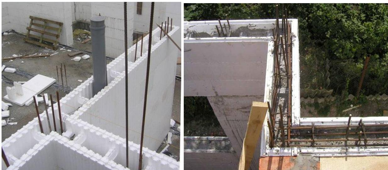
Рисунок 2.12 – Постройка термодома
