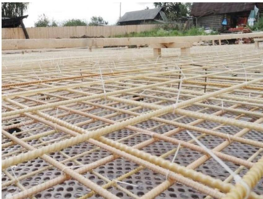
Рисунок 2.7 – Построение домов с композитной арматурой.
