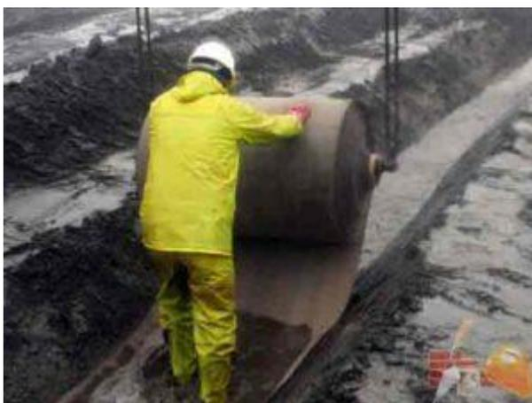
Рисунок 2.15 – Использование бетонного холста
