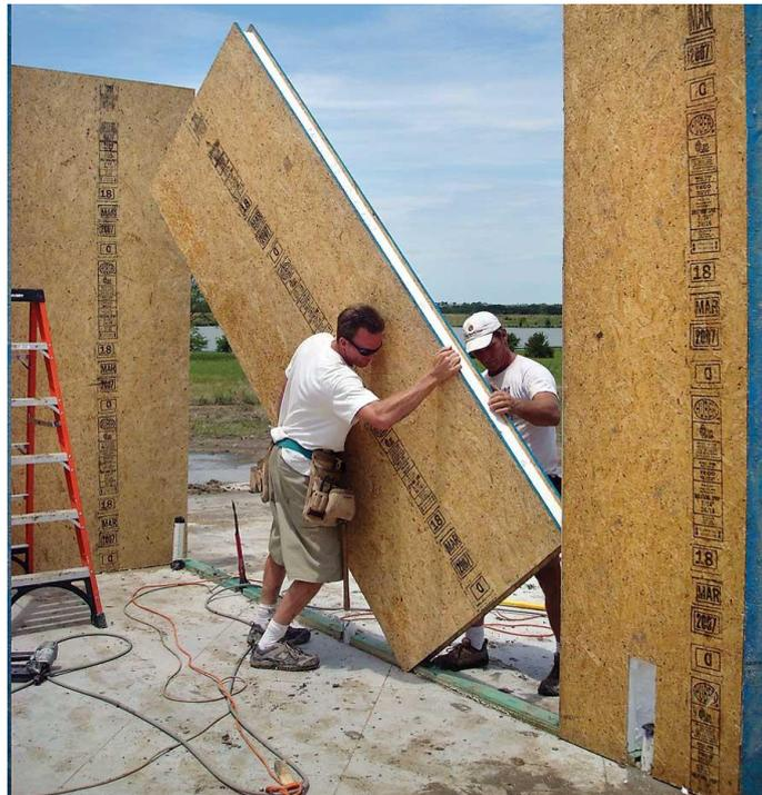
Рисунок 2.10 – Постройка домов из Сип панелей
