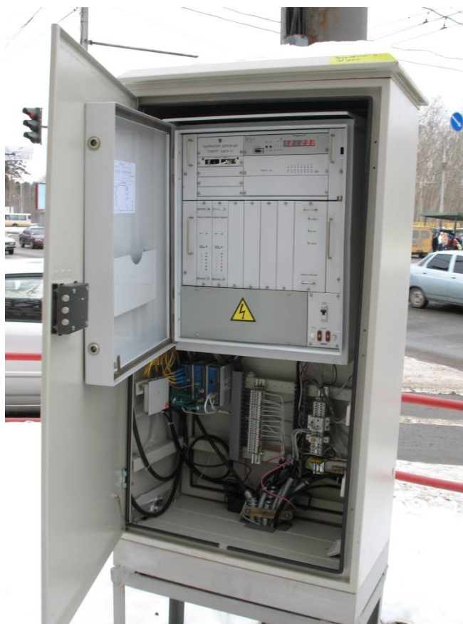
Рисунок 3.1 – Внешний вид дорожного контроллера СПЕКТР - КДСФ Контроллер обеспечивает в цикле:
