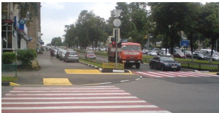
Рис. 2.5. Обустройство пешеходных переходов цветной разметкой
