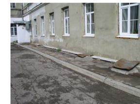
Разрушение отмостки по периметру здания
