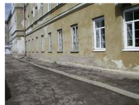
Разрушения кирпичной кладки по фасаду здания и отделочного слоя здания
