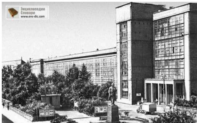
Автозавод им. И. А. Лихачёва в Москве. Моторный корпус. 1934—37. Архитекторы Е. М. Попов, В. Н. Златолинский и др., инженер М. С. Волчегорский и др.
