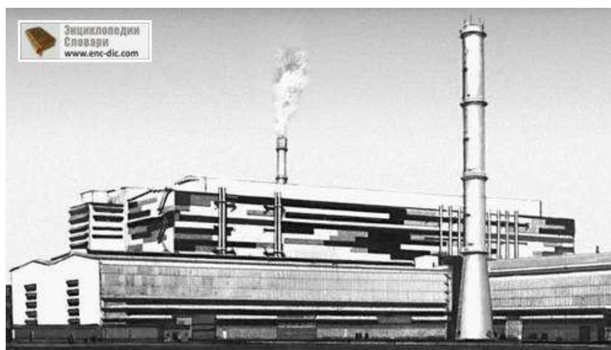
Металлургический завод близ Исфахана (Иран). Конвертерный цех, 1960-е гг. Советские архитекторы В. С. Пермогенский, Г. В. Вольфензон, Е. Ф. Лунин.
