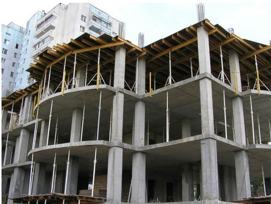
Рис. 1. Общий вид на монолитный железобетонный каркас многоэтажного здания
