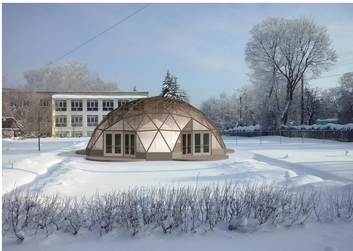
Рис. 1.1. Купольное покрытие оранжереи
