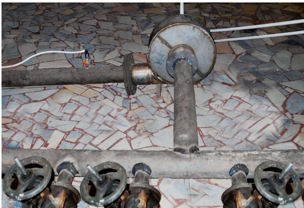
Рис. 5.2. Общий вид вихревого смесителя, распределительной линии и дроссельных устройств
