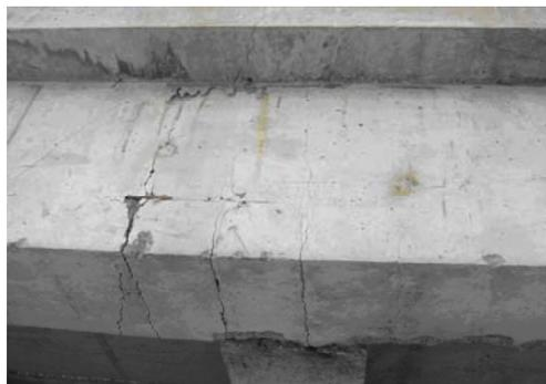
Рис. 3. Серия трещин в основном ригеле шириной раскрытия до 5,0 мм (в сопряжении с пасынковым ригелем)
