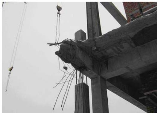
Рис. 1. Разрушение конструкций перекрытия над первым этажом вблизи узлового сопряжения ригелей с колонной
