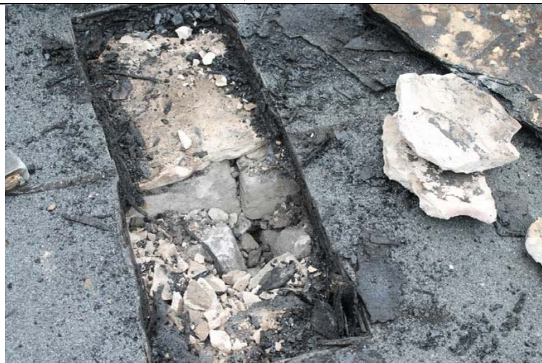
Рис. 7. Шурф в средней части кровли
