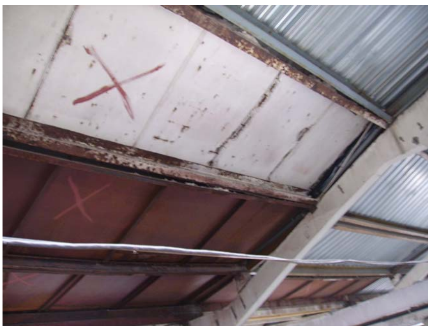
Рис.1. Неправильная постановка несущих продольных швеллеров
