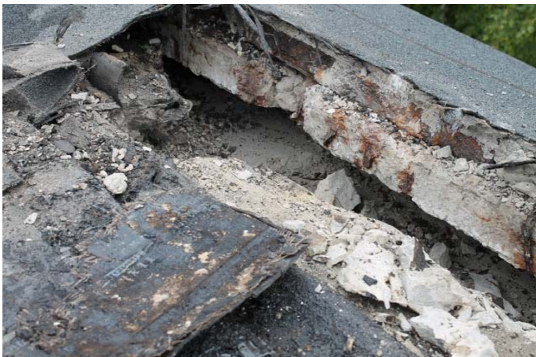
Рис. 6. Шурф у карнизной плиты
