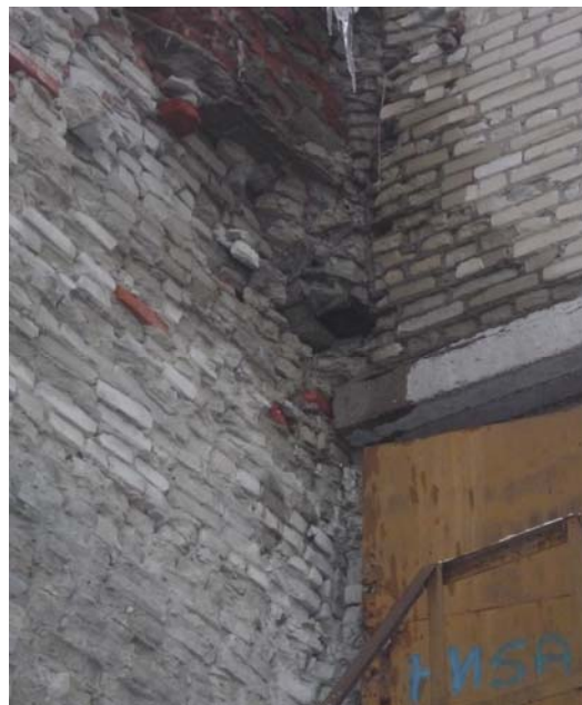
Рис. 4. Отсутствие отлива на крыше
