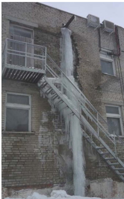
Рис. 3. Некачественный водоотвод
