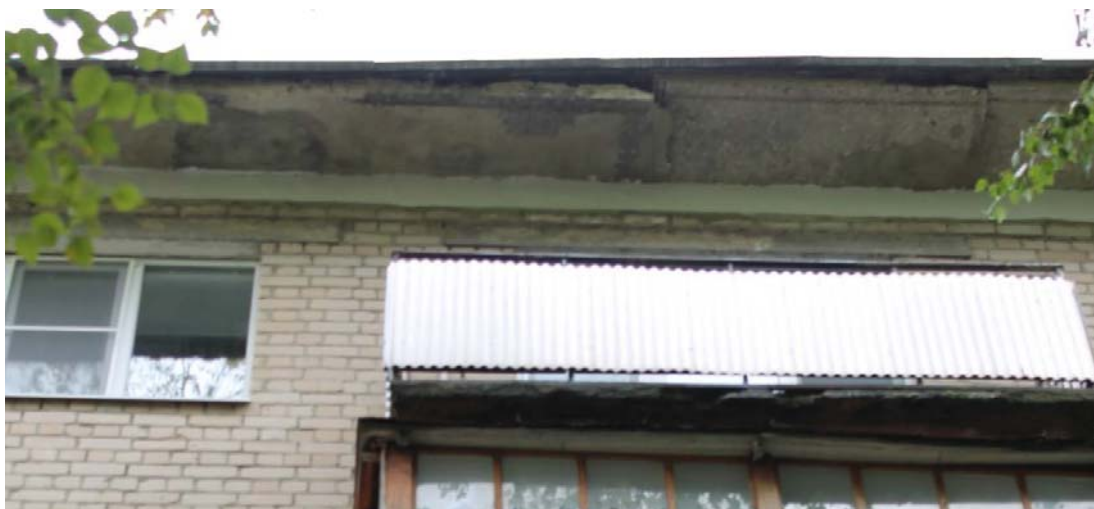
Рис. 5. Крен карнизных плит
