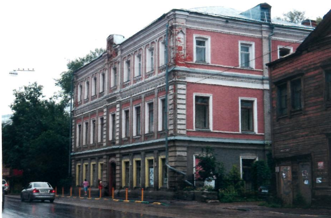
Рис. 2. Здание Ремесленной управы (ул. Октябрьская, 25) до реставрации
