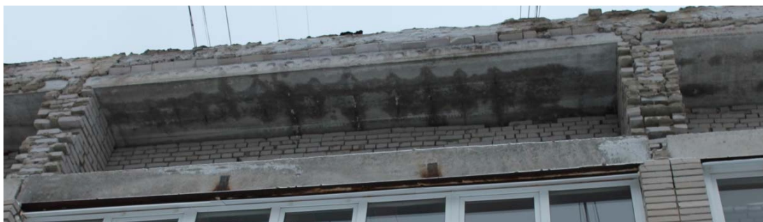
Рис. 8. Отсутствие анкеров и сеток в местах крепления стенового ограждения к боковым стенам и перекрытию лоджии 9-го этажа
