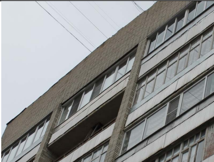
Рис. 2. Крен стенового ограждения лоджии 9-го этажа
