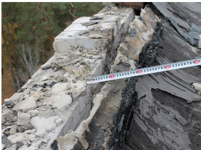
Рис. 1. Прогрессирующая трещина шириной раскрытия 8 см между перекрытием и наружным ограждением лоджии
