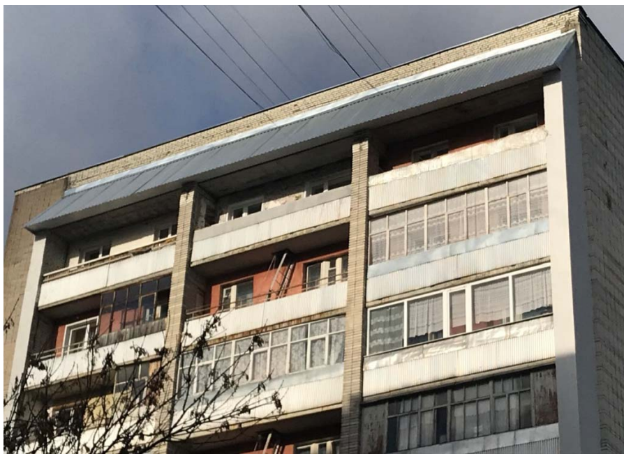
Рис.11. Фасад жилого дома после реновации
