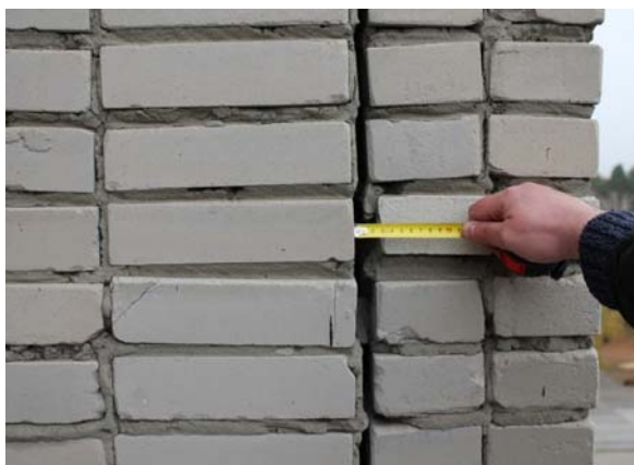
Рис. 6. Пример расслоения кирпичной кладки боковых стен лоджий
