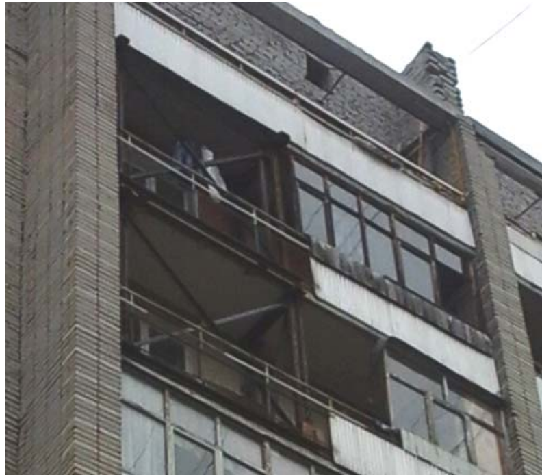
Рис.9. Страховочные конструкции на лоджиях 7-го и 8-го этажей
