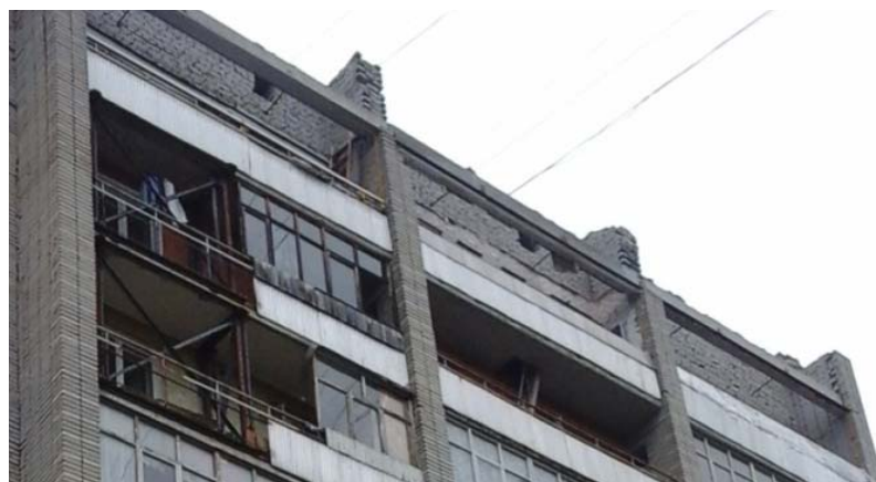
Рис.10. Вид фасада без стенового ограждения и перекрытий лоджии 9-го этажа
