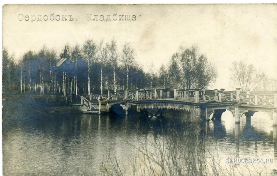
Рис.5. Мост между парком и кладбищем
