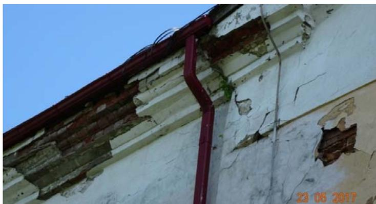
Рис. 2. Протечки желоба и воронки крыши
