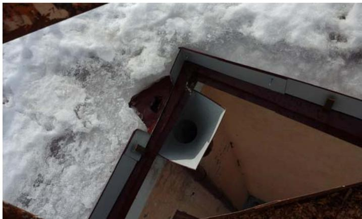
Рис. 5. Типичный вид приемной воронки системы водоотвода с крыши после ремонта
