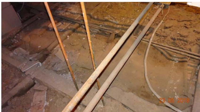
Рис. 8. Некачественная укладка утеплителя
