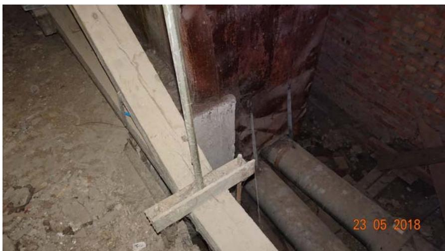
Рис. 13. Отсутствие теплоизоляции на коммуникациях
