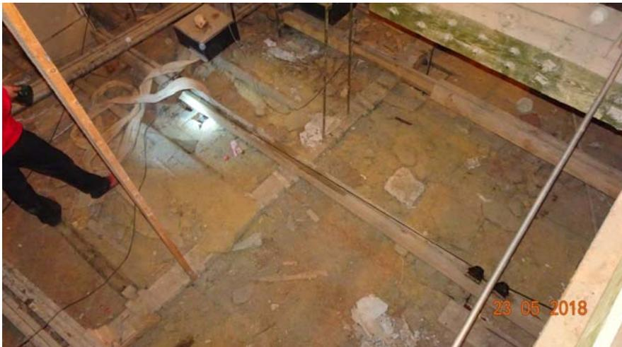
Рис. 12. Сквозное отверстие в перекрытии
