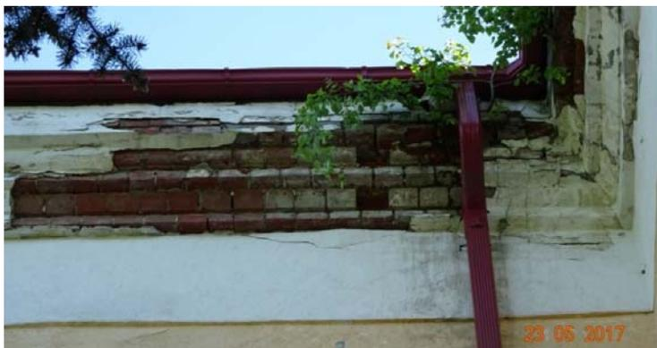
Рис. 3. Протечки желоба и воронки крыши
