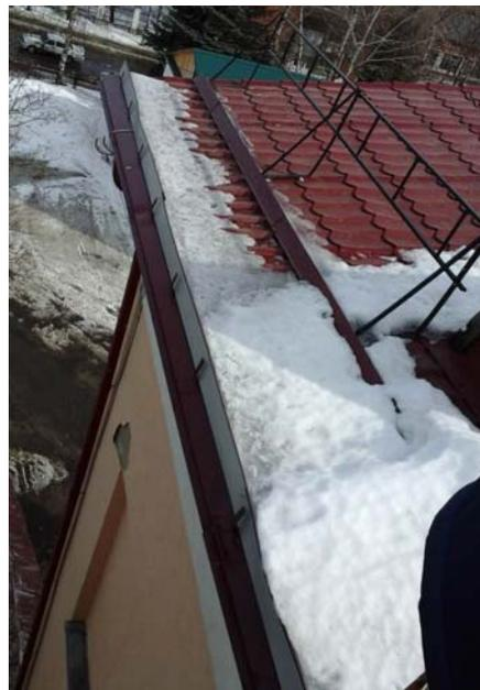
Рис. 1. Снеговой «мешок» на карнизном свесе крыши после ремонта
