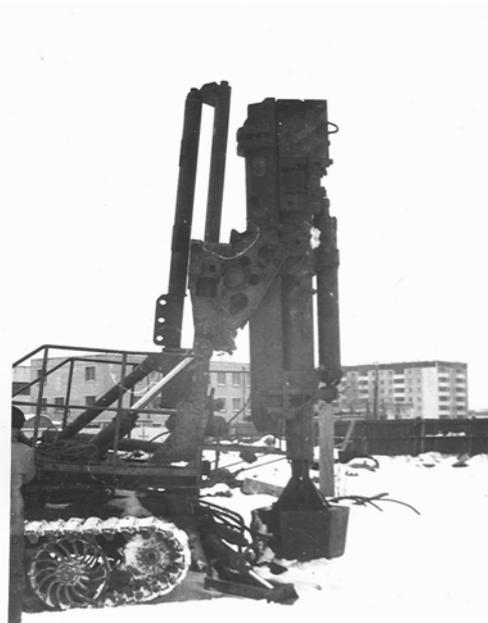
Рис. 4. Установка УЗАС-2 с застреливаемым в грунт штампом
