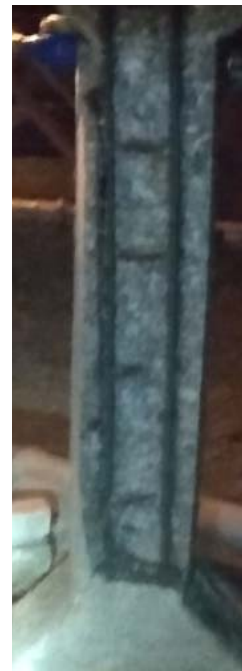
Фото 3. Полное разрушение железобетонной стойки
