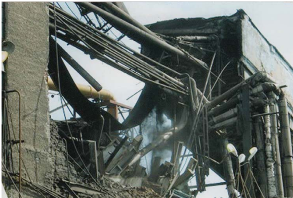
Рис. 2. Общий вид обрушения железобетонных плит и стальных ферм покрытия Барнаульской ТЭЦ-2 (26 марта 2006 года)
