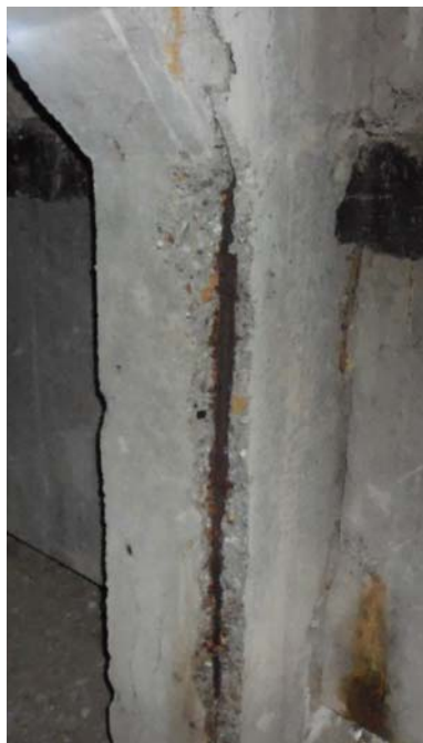
Фото 2. Разрушение стойки железобетонной рамы высокой степени
