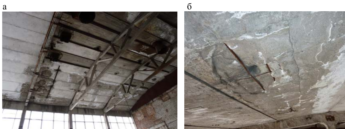
Рис. 1. Фрагменты конструкции покрытия производственного цеха: а – общий вид покрытия; б – характерное повреждение плит из ячеистого бетона (отслоение защитного слоя, коррозия арматуры)
