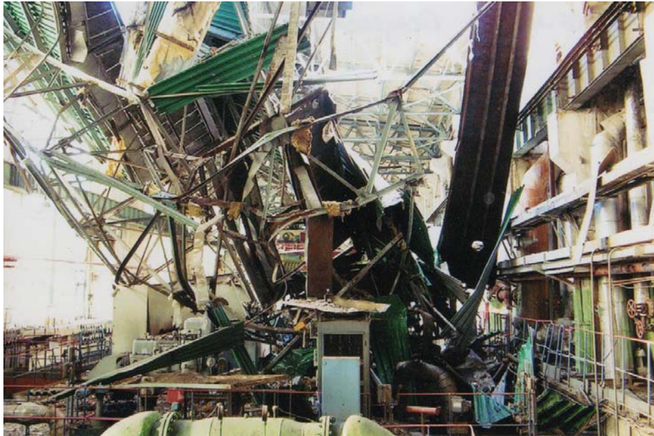
Рис. 1. Общий вид обрушения железобетонных плит и стальных ферм покрытия Пензенской ТЭЦ-1 (26 января 2017 года)
