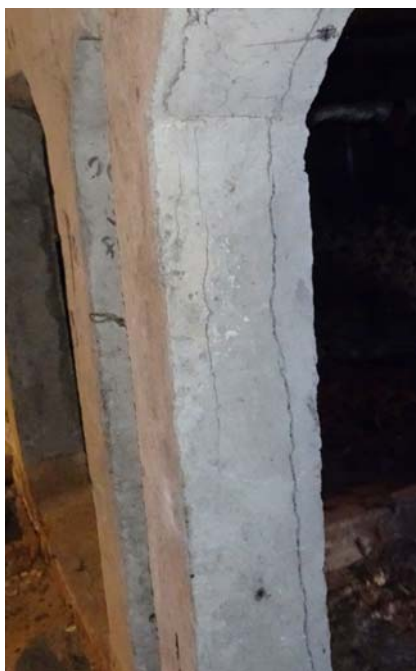
Фото 1. Разрушение стойки железобетонной рамы средней степени
