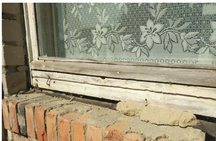
Рис. 3. Рассыхание деревянной рамы в школе Шемышейского района Пензенской области
