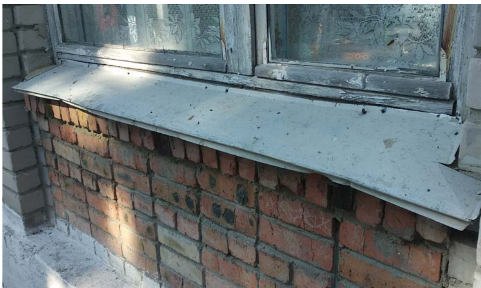
Рис. 4. Кирпичная основа под металлические отливы
