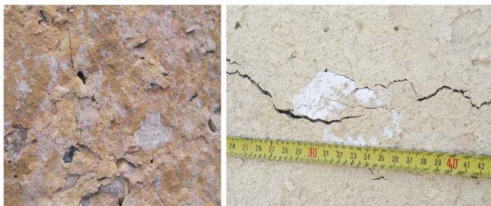
Рис. 3. Разрыв сплошности цементной матрицы вокруг заполнителя и образование поверхностных трещин вдоль арматурных стержней
