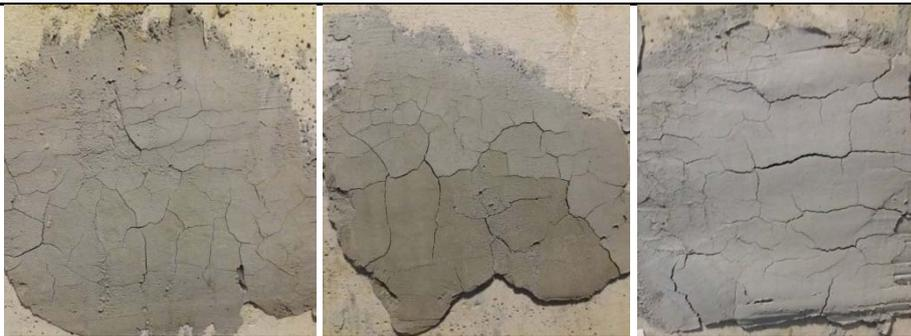
Рис. 1. Трещины на поверхности бетонного слоя
