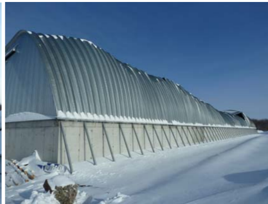
Рис.3б. Фасад склада муки в осях 1-61
