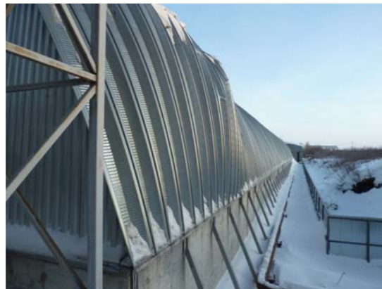
Рис. 3а. Фасад склада сахара в осях 1-61
