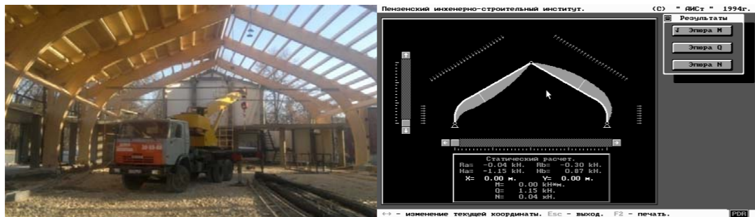
Рис. 4. Монтаж деревянных рам и эпюра моментов (программный комплекс PDR, вид экрана)
