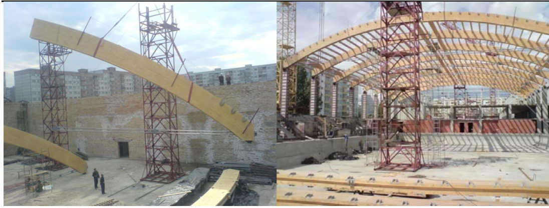
Рис. 2. Монтаж деревянных арок при строительстве СК «Буртасы» в Пензе (2006-2008 гг.)
