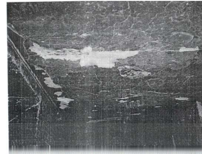
Рис. 3. Потолочная поверхность пустотной плиты после пожара. Наличие трещин, отслоение защитного слоя (местами)
