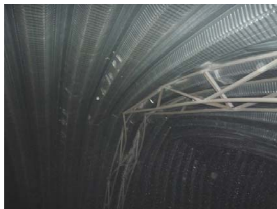
Рис. 4а. Вид обрушения фермы сахарного склада между осями 55-56
