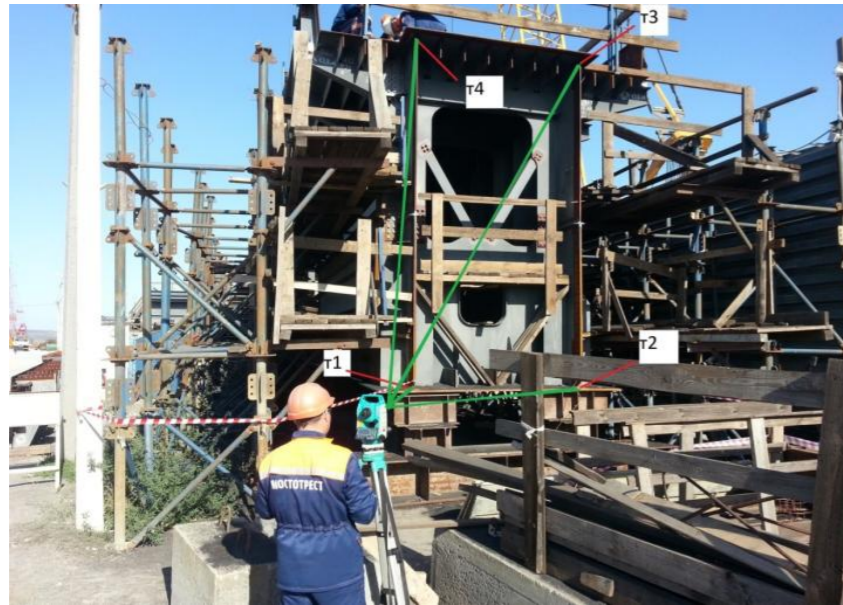
Рис. 2. Определение геометрических размеров укрупняемого блока ПС
