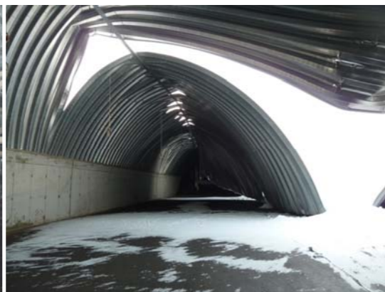
Рис. 4б. Общий вид обрушения арочного покрытия ангара с мукой со стороны оси А
