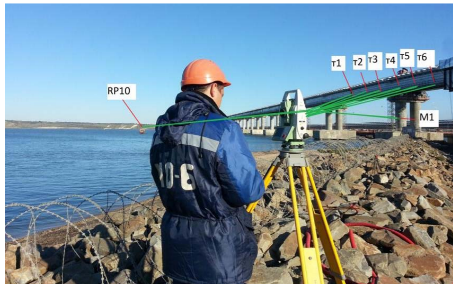
Рис. 7. Контроль планового положения блоков ПС и общей прямолинейности конструкции ПС
