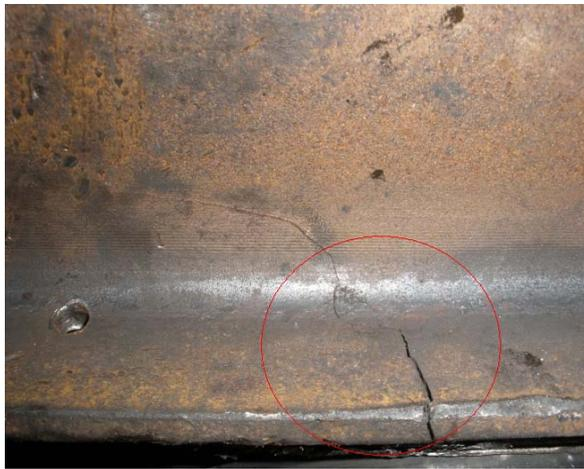
Рис. 6. Усталостная трещина в балке № 2
