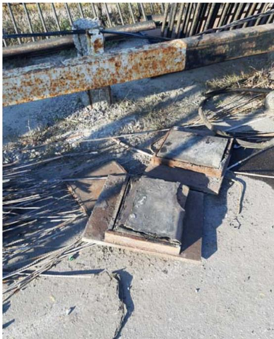
Рис. 5. Нарушение целостности листа рубероида (гидроизола) опорной части железобетонного моста
