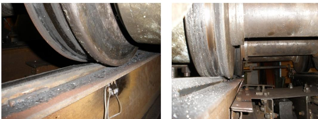
Рис. 2. Подвижные воздействия колёс кранов на прокатные балки
