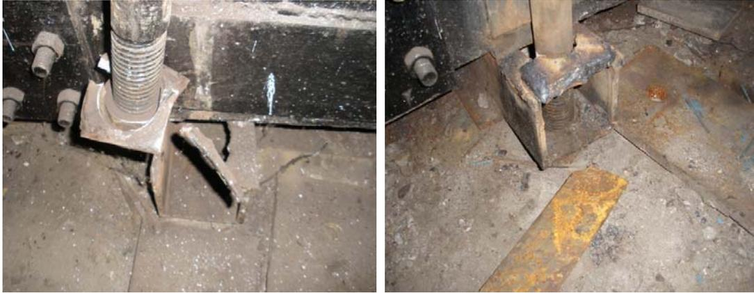
Рис. 5. Усиление сварного узла
