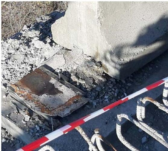
Рис. 3. Раздавливание РОЧ. Место положения – крайняя балка пролетного строения
