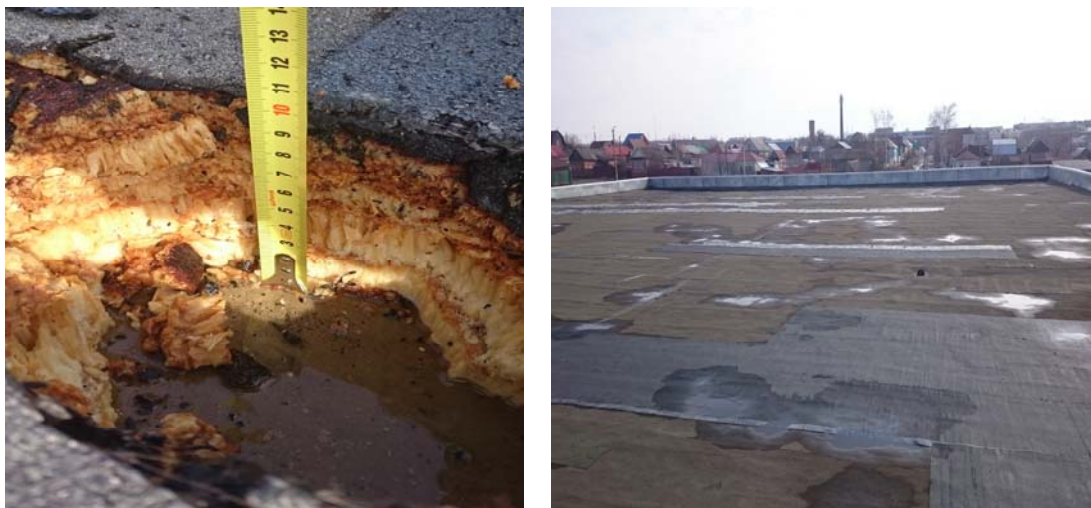
Рис. 2. Замачивание утеплителя на кровле бассейна в г.Сердобске, Пензенской области
