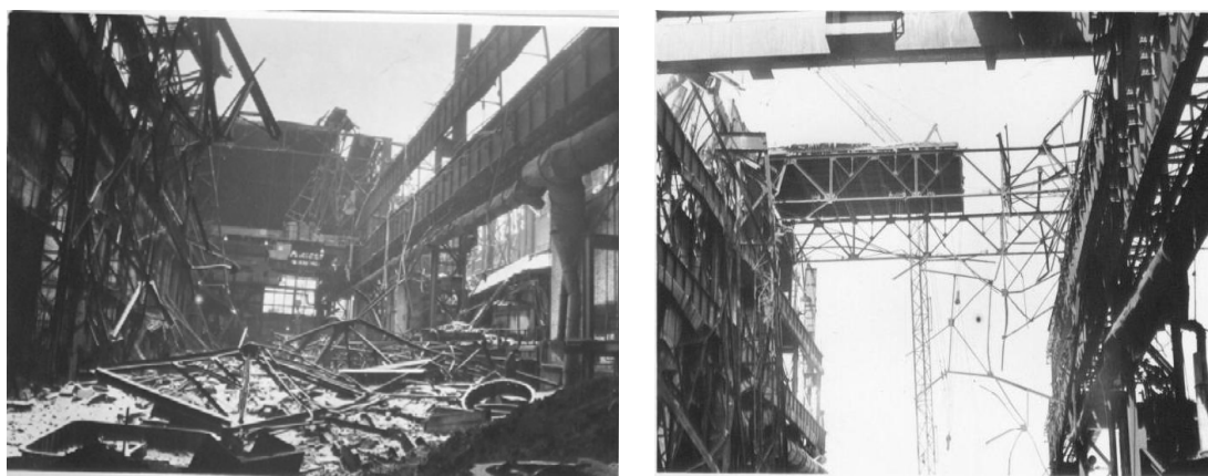
Рис. 1. Цех после обрушения
