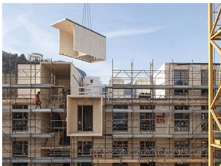
Рис. 5. Монтаж CLT-панелей
