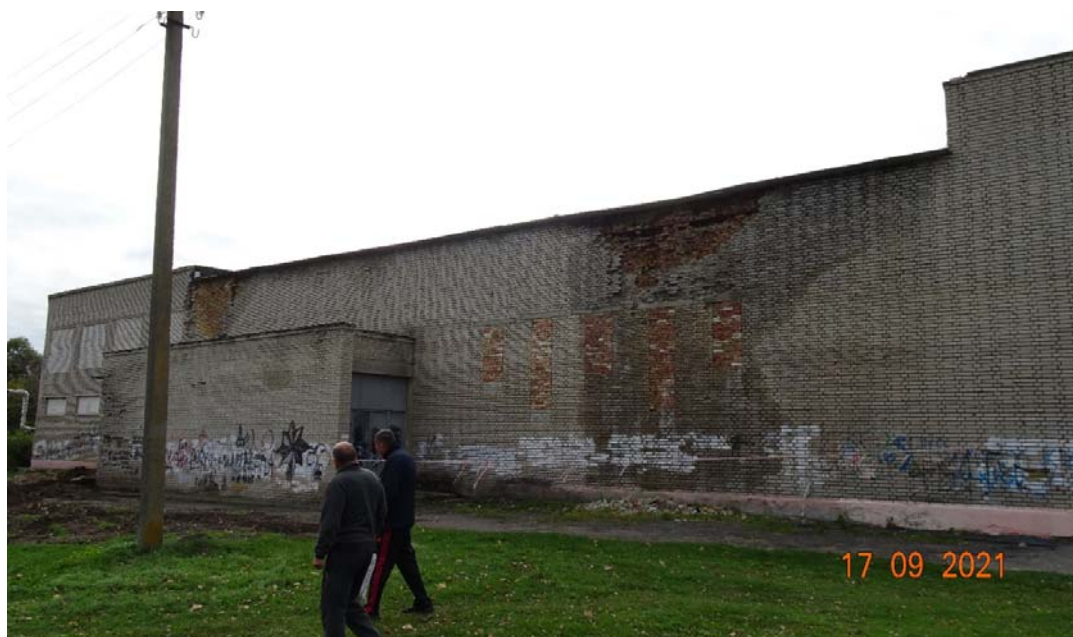
Рис. 3. Несущая стена зрительного зала
