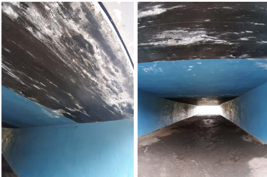
Рис. 4. Использование углеродистого тканого холста для усиления мостового полотна
