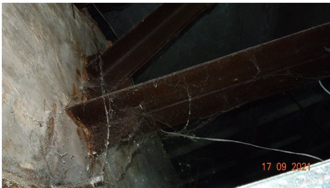
Рис. 5. Опорный узел стропильной фермы
