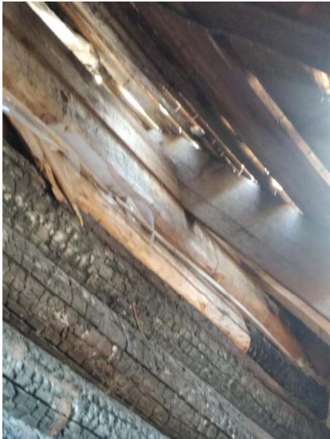
Рис. 9. Разрушение бревен стены здания в результате пожара
