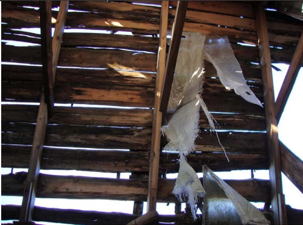
Рис. 6. Обрешетка расположена на верхнем поясе арок (обрешетка вдоль буквенных осей здания). На левой арке видно, что соединение арки с повышенной затяжкой выполнено врубкой полусковороднем. Фото Селютиной Л.Ф.
