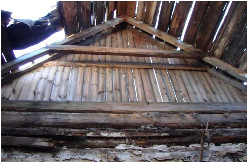
Рис. 7. Торцевая арка здания. Крепление повышенной затяжки к стропильной ноге производится врубкой полусковороднем. Чердачное перекрытие разрушено. Фото Селютиной Л.Ф.
