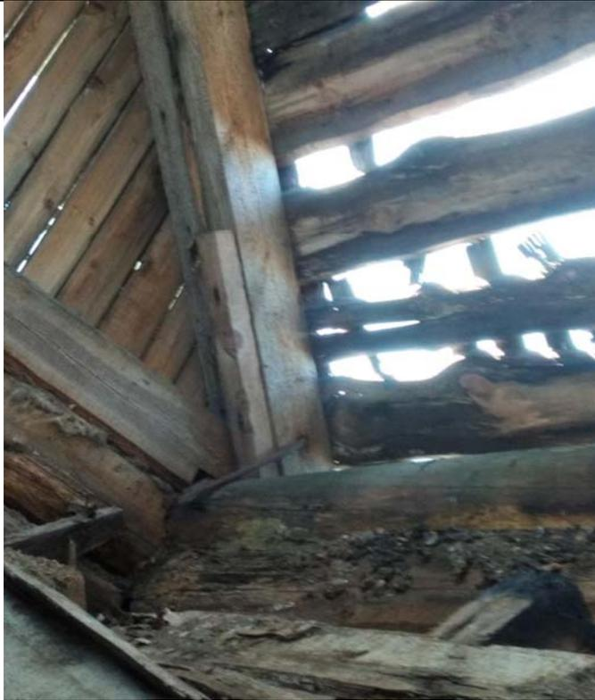
Рис. 8. Узел сопряжения элементов чердачного перекрытия и арки крыши.
