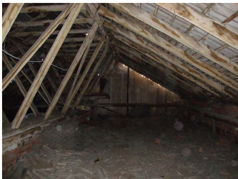
Рис. 3. Фрагмент стропильной системы жилого здания в Кондопоге
