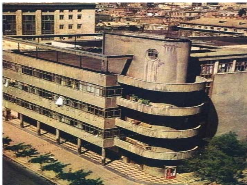
Рис. 2. Здание «Азернешр», г.Баку
