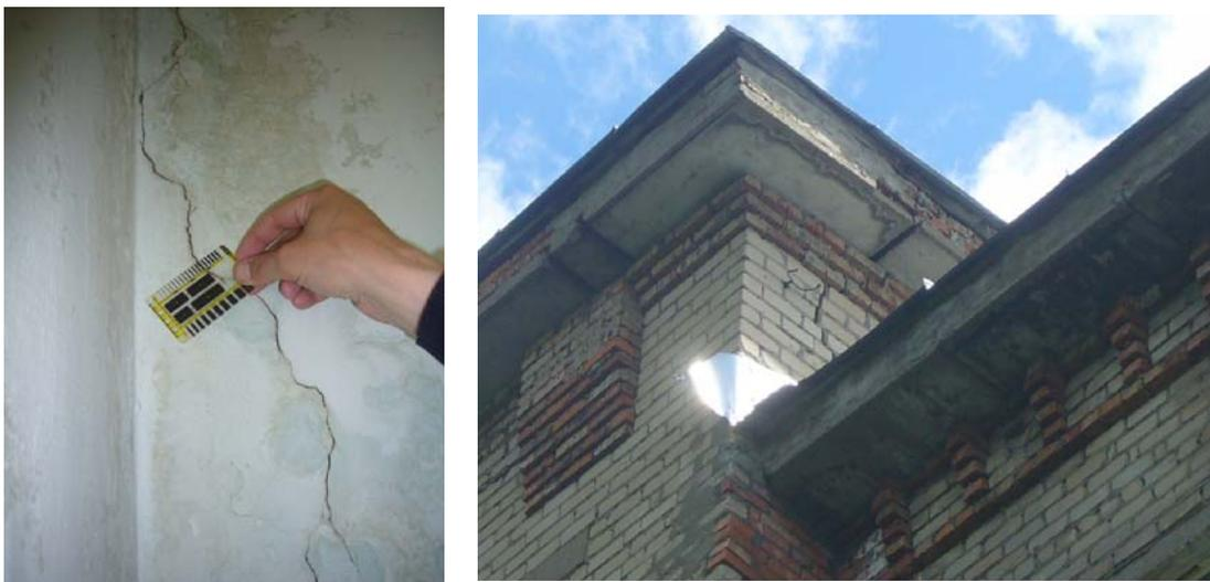
Рис. 2. Характерные трещины в стенах корпуса
