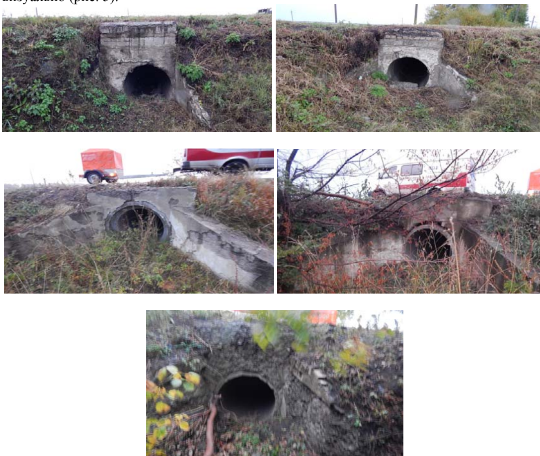
Рис. 5. Фотофиксация железобетонных искусственных сооружений
