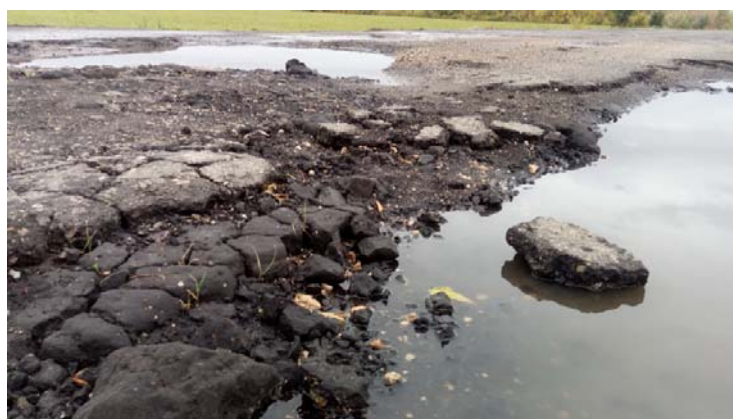
Рис. 4. Фотофиксация образцов (кернов) и состояния дорожного покрытия
