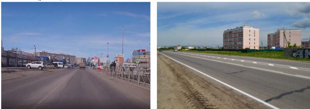
Рис. 1. Участок автомобильной дороги «г. Пенза – р.п. Шемьшейка – с. Лопатино» до реконструкции
