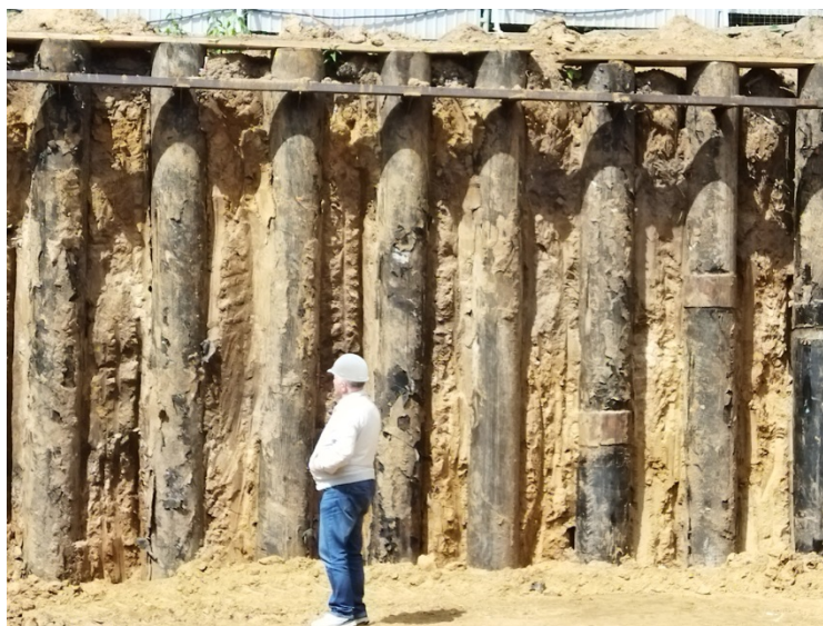
Рис. 1. Вид подпорной стенки
