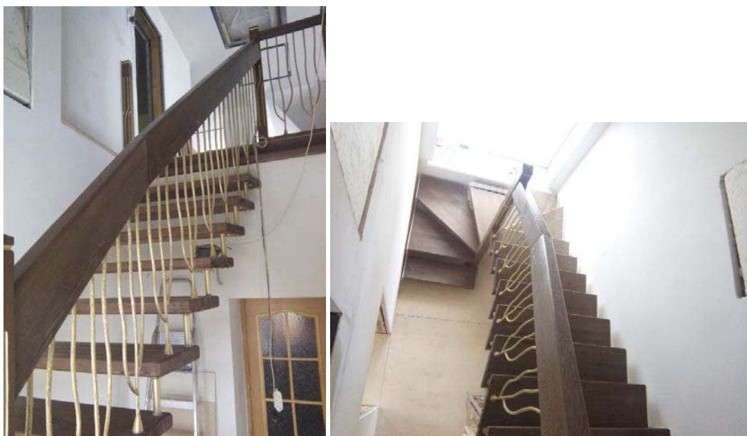
Рис. 8. Фото лестницы с изменяемой шириной марша на выходе
