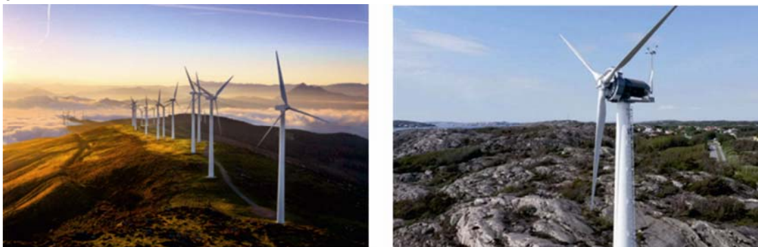
Рис. 11, б. Ветровая электростанция на деревянной опоре близ Гётеборга
