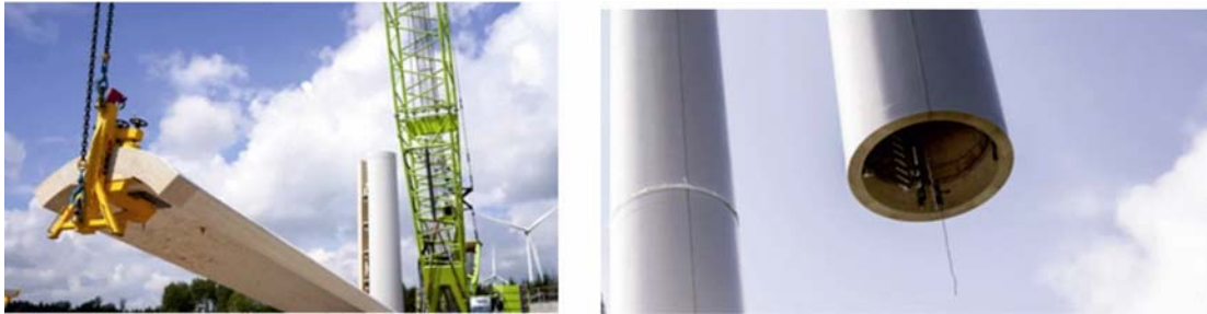
Рис. 11, а. Монтаж ветровой электростанции на деревянной опоре. Швеция. 105 м. 2023 г.
