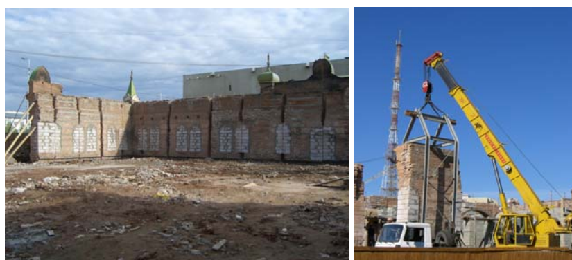
Рис. 5. Укрепление кирпичных стен обмуровкой оконных и дверных проемов, г. Якутск (фото А.Е. Местникова)
