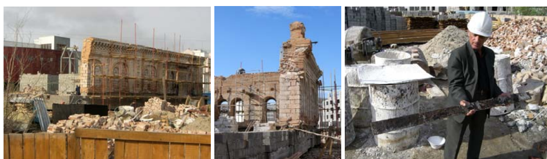
Рис. 6. Установка и крепление цельных кирпичных блоков на свайный фундамент, г. Якутск, 08.06.2006 г. (фото А.Е. Местникова)
