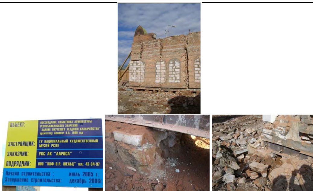
Рис. 4. Укрепление основания кирпичной стены закладкой металлических профилей, г. Якутск (фото А.Е. Местникова)
