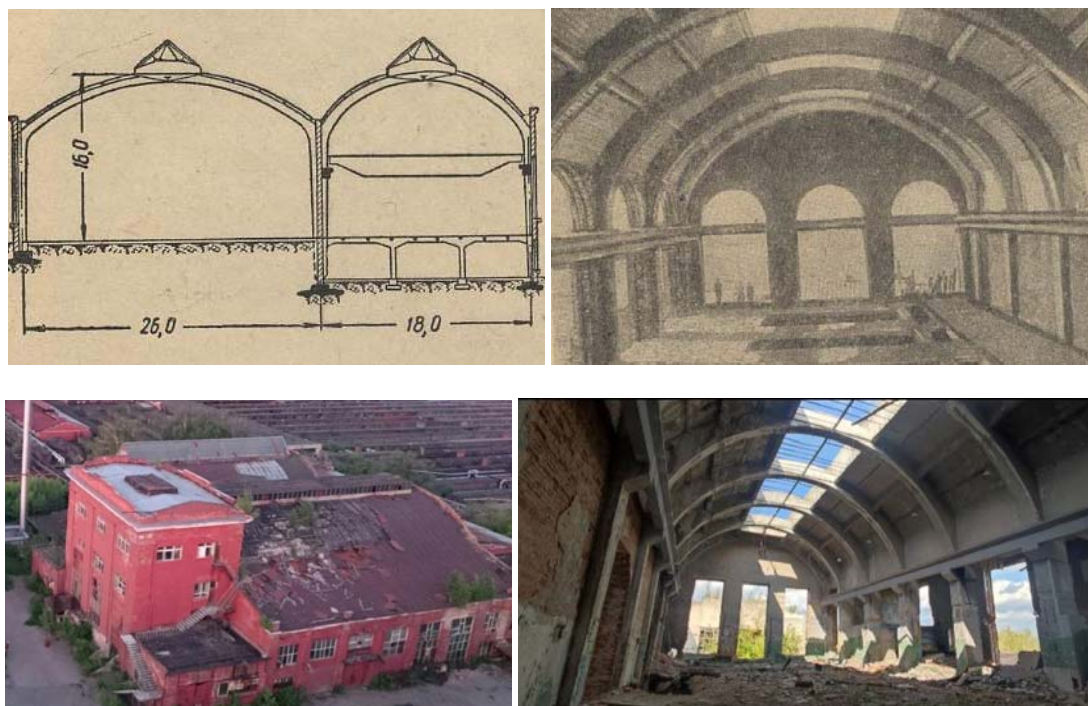
Рис. 6. Здание силовой станции. Сравнение иллюстраций из книги П.Л. Пастернака ([2] сверху) и современного состояния цеха (внизу, фото из интернета)
