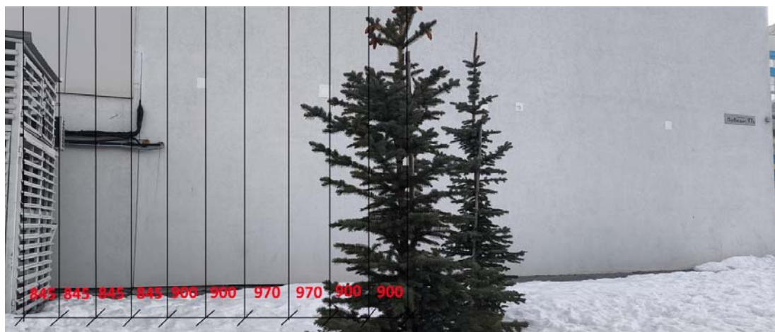
Рис. 2. Внешний вид обследуемого объекта
