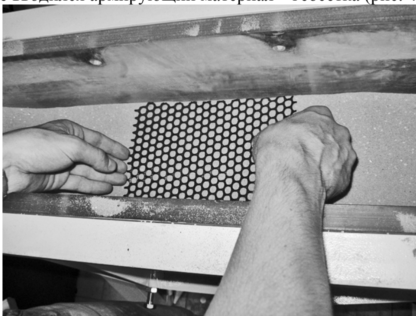
Рис. 4.25. Укладка армирующих сеток
