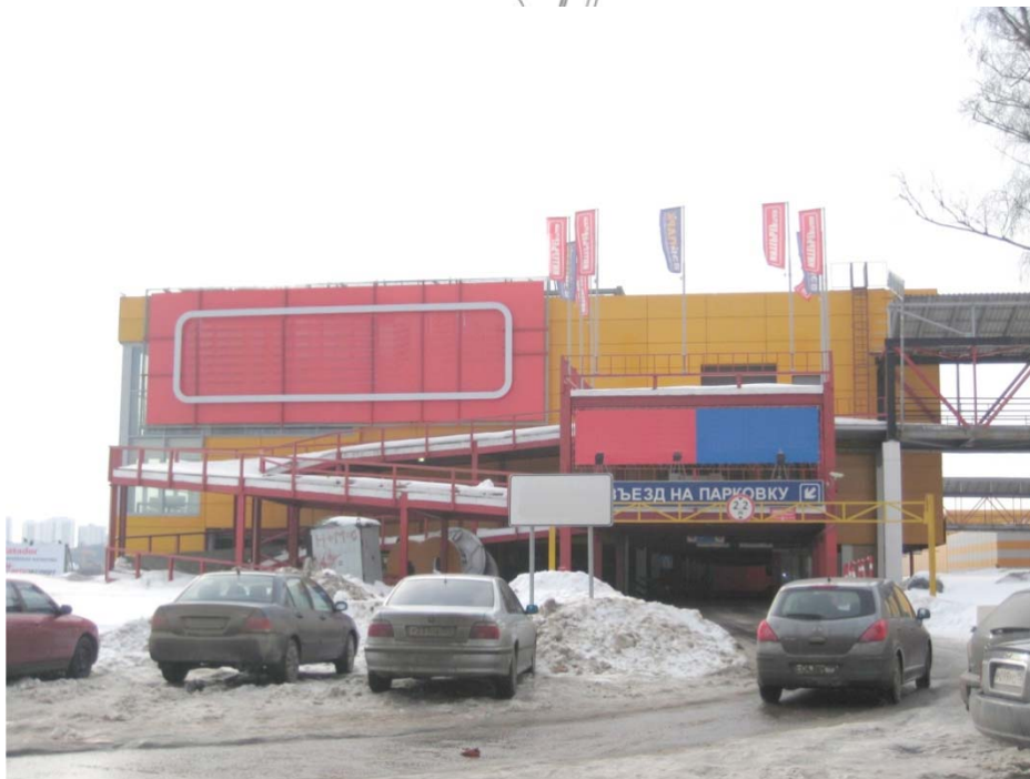
Рис. 25П. «Вэйпарк» Московская область, МКАД 71-й километр, 2004 г., Nps Tchoban Voss (фото автора)
